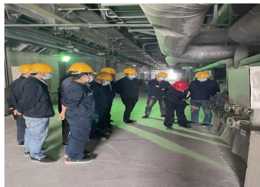
图 4-3 大柴旦锅炉操作工培训
